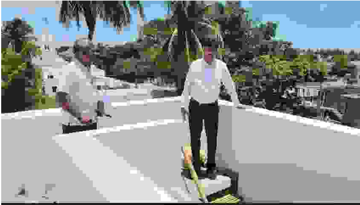
ஈரோடு மாவட்டம், அவல்பூந்துறை பேரூராட்சி, பாரதியார் நகர்பகுதியில் கலைஞர் நகர்ப்புற மேம்பாட்டுத் திட்டத்தின் கீழ் கட்டப்பட்டுள்ள சமுதாயக் கூட கட்டிடத்தின் கட்டுமானப் பணிகளை மாவட்ட ஆட்சித்தலைவர் ச.கந்தசாமி, நேற்று (01.09.2026) நேரில் பார்வையிட்டு, ஆய்வு மேற்கொண்டார்.
